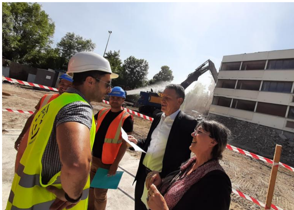
Le directeur général de la Semcoda, en discussion avec Anthony Louis, chargé de projet, de renouvellement urbain pour la Semcoda, au premier jour de démolition de la tour. Photo Serge Spadillero
